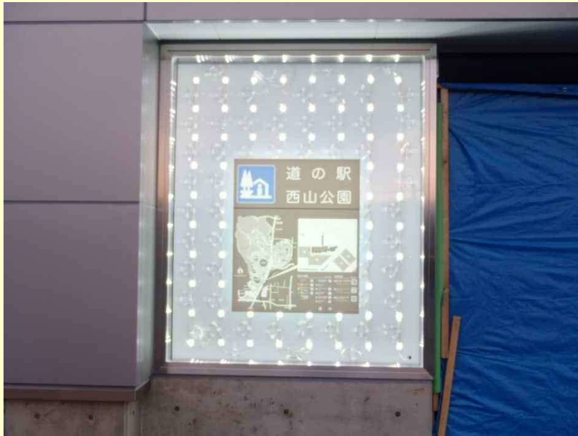
道の駅案内板（施工中）
