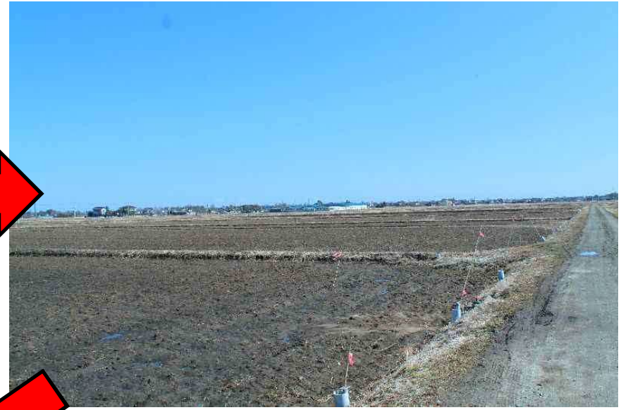
工事完了・地元引渡
