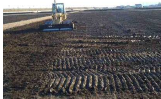
⑤弾丸暗渠施工
