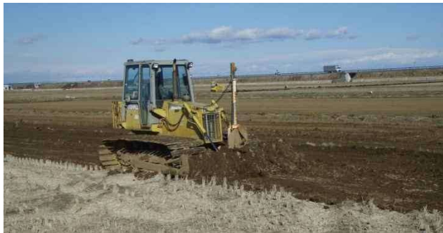
②-3 ブルドーザ集土
