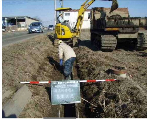
②-1排水路土砂撤去
