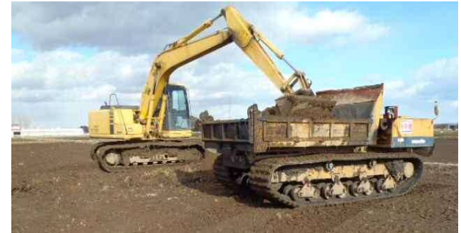
②-4 畦畔付近堆積土砂はぎ取り
