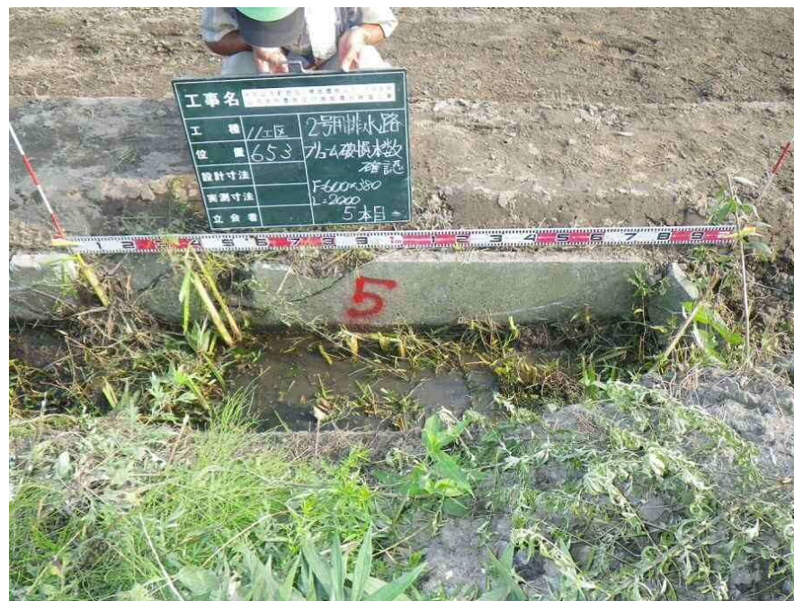
水路の破損状況調査
