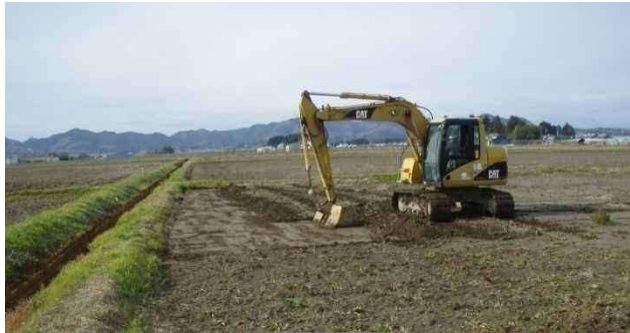
②-2 畦畔付近堆積土砂はぎ取り
