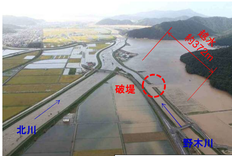
破堤状況 (H25.9.16撮影)
