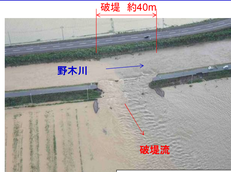
破堤状況 (H25.9.16撮影)
