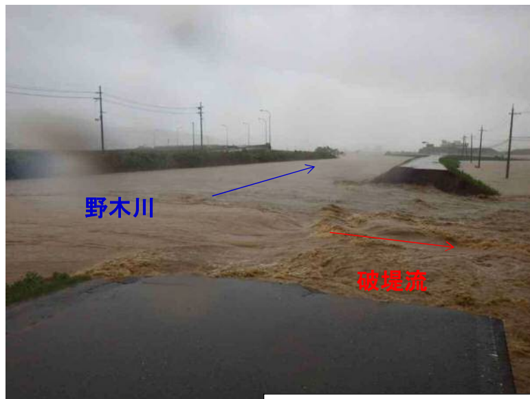
破堤断面 (H25.9.16撮影)
