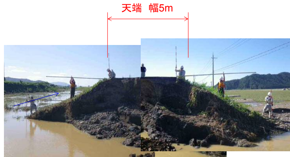
破堤断面 (H25.9.17撮影)
