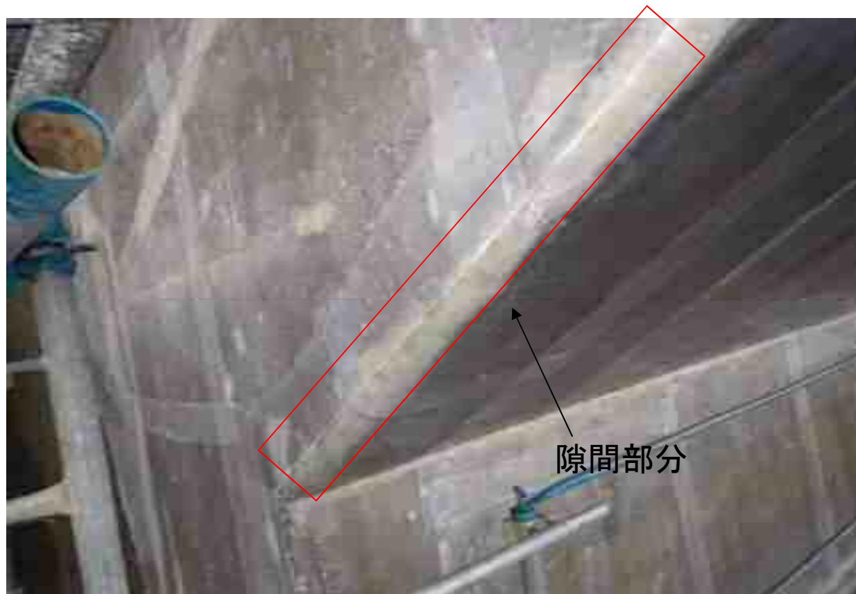
ビニロン繊維シートを貼付けた状況
