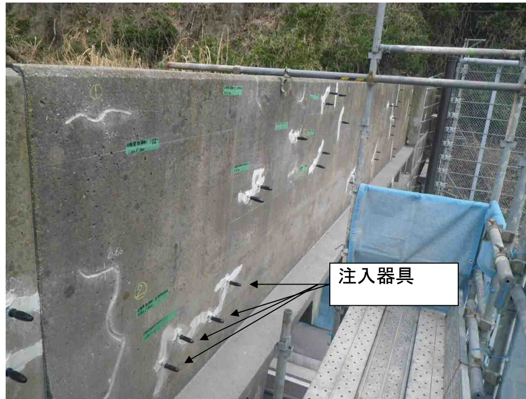
注入工法の状況
