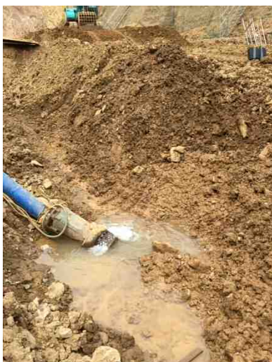
釜場排水実施状況(中央部下流側)
