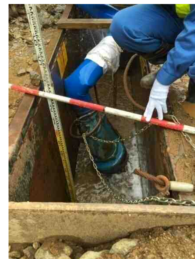
釜場排水実施状況(中央部上流側)
