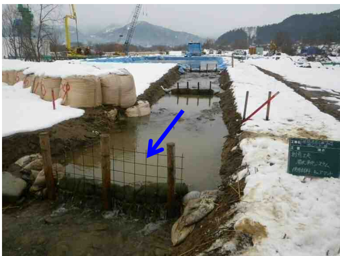
放流部へのフィルター材設置
