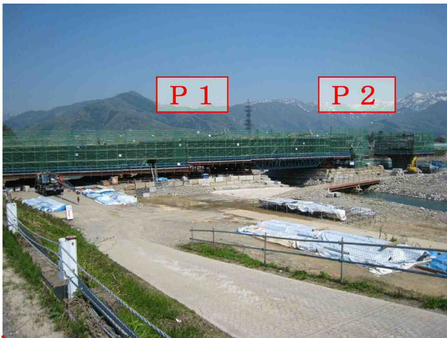
固定支保工架設工法
