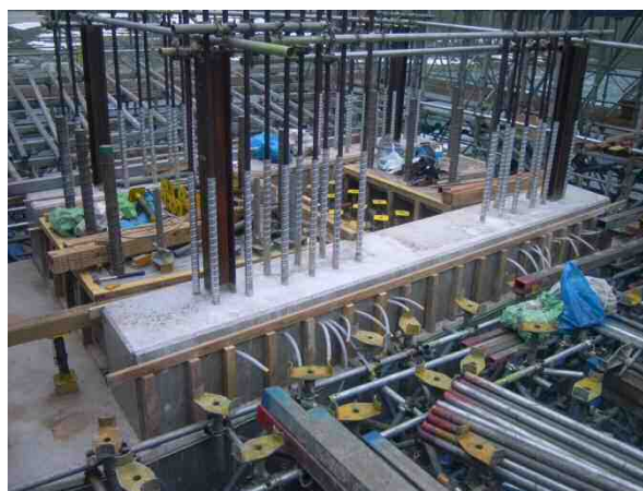
仮支承コンクリート脱型
