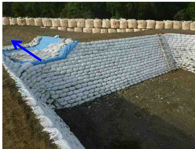
沈殿池の設置(放流部)
