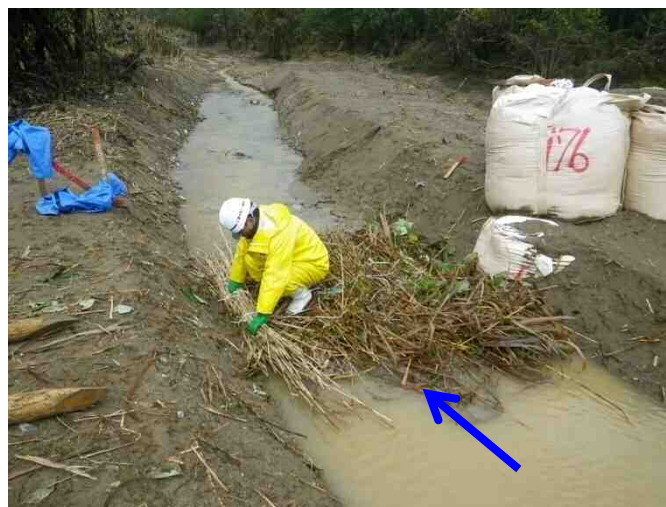
放流部最下流のフィルター材(現地採取材)
