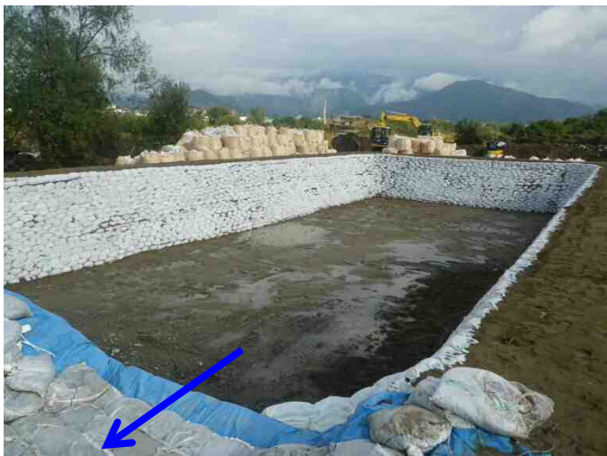
沈殿池の設置
