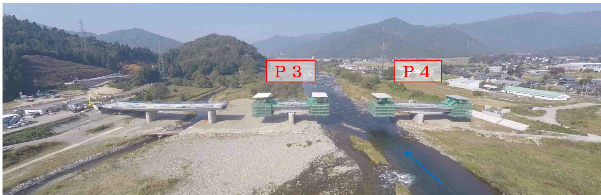
架設作業車(ワーゲン)
