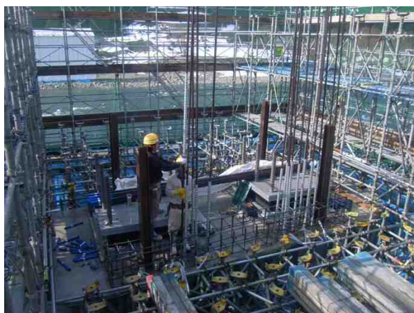
PC鋼棒設置
