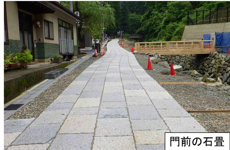
町道志比2号線を1600年代の古地図に基づく旧参道として再生する事業で、永平寺町が整備主体となりました。無電柱化および参道の石畳化、緑化を行うもので、平成30年8月に完成予定です。
