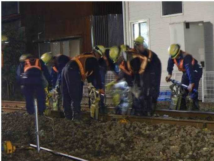
バラスト締固め状況
