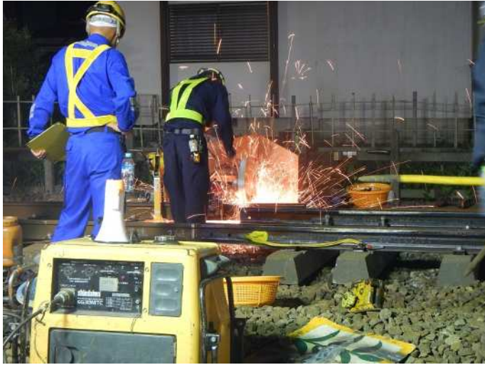
レール切断状況
