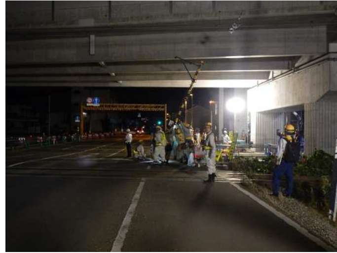
踏切切替状況
