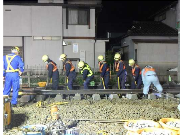
レール移設状況
