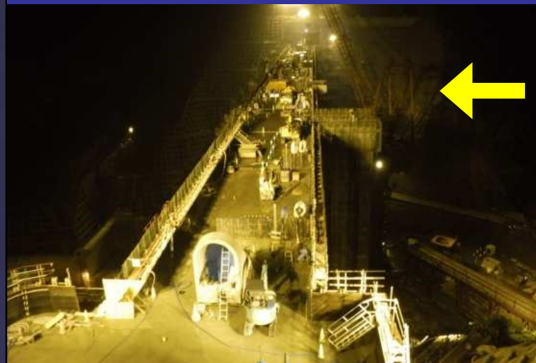
夜間コンクリート打設作業の様子①
