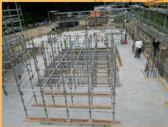
支保工足場が先行解体出来る計画
