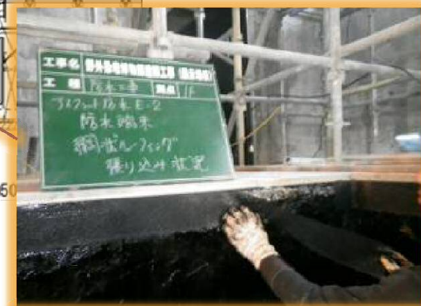
内装工事と防水工事の同時施工
