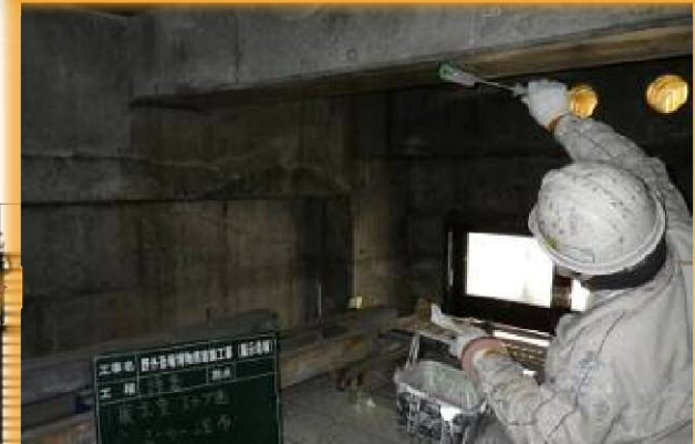
支保工足場を塗装用足場に再整備
