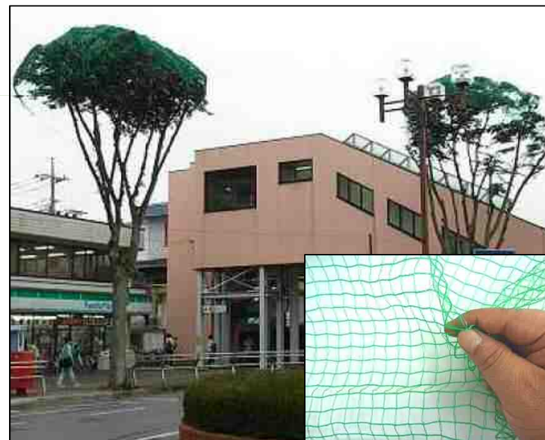
【防鳥ネットの設置事例】
