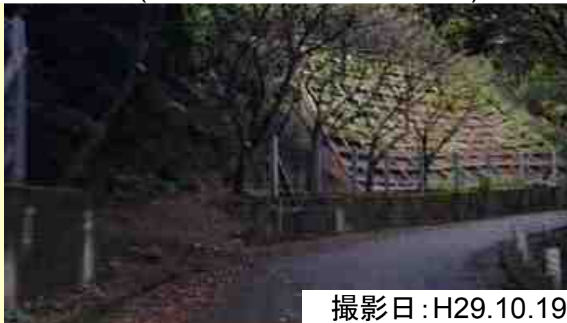
被災前状況(終点→起点No.4+4.7付近)
