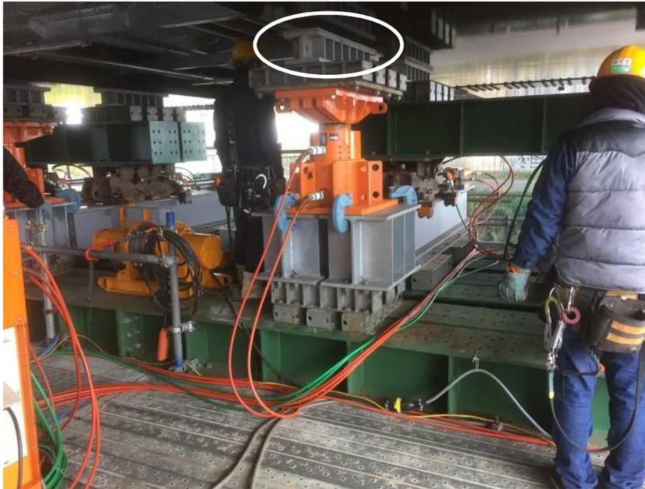
スライドジャッキで架設桁を送り出している状況
