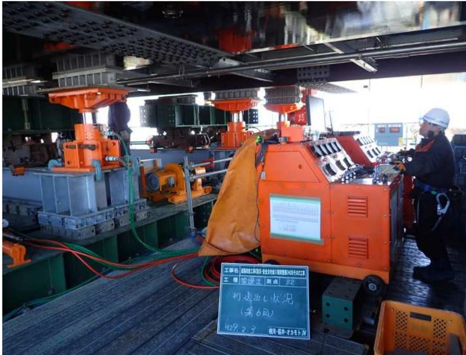
この操作盤からの指令で全て（軌条設備、各橋脚）の送出し装置が連動して動く
