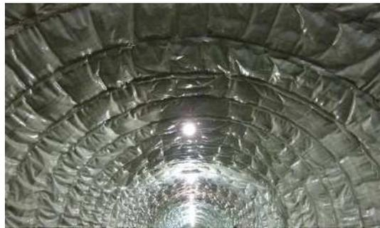
FILM工法 (覆工内面平滑工法)
