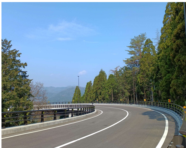
付帯施設設置・舗装を行い完成
