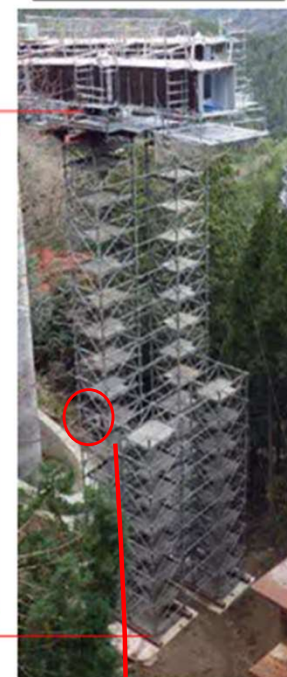
本工事のベント
