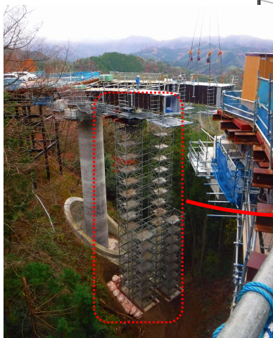
仮支柱（ベント）
