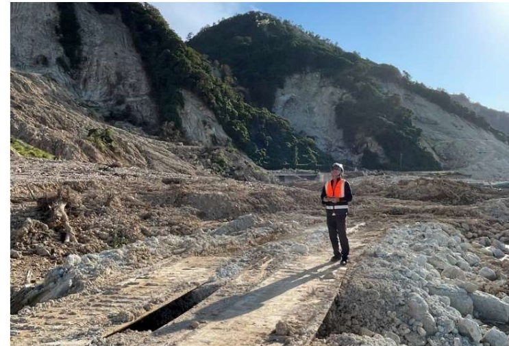
9月30日 ドローン撮影状況 被災状況調査
